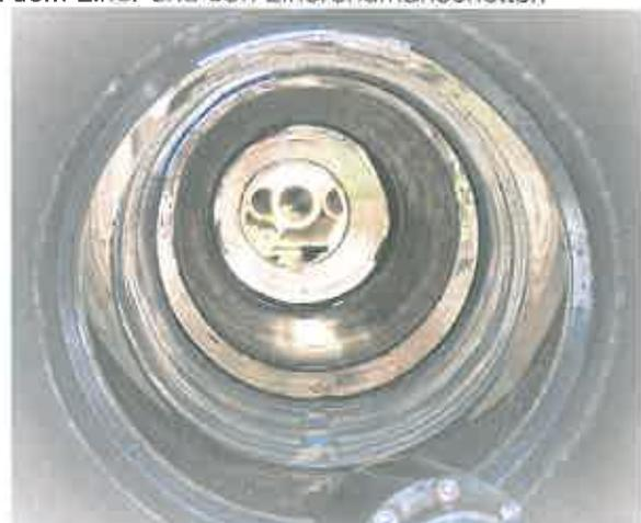
Bild 4: Blick auf eine Circum-LEM im Betonrohr
