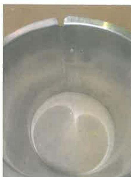
Bild 1: Linerendmanschette Circum-LEM, DN 300
