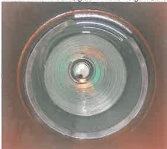
Bild 3: Blick auf eine Circum-LEM im Steinzeugrohr
