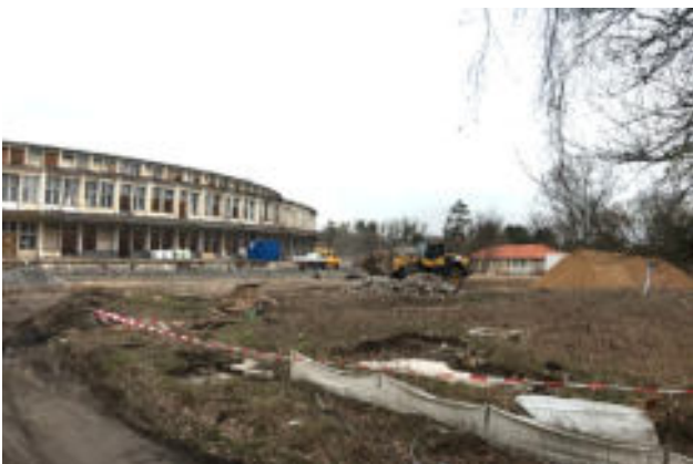
Bild 4: Der Speisesaal der Nationen wird komplett saniert und zu Wohnungen umgebaut
